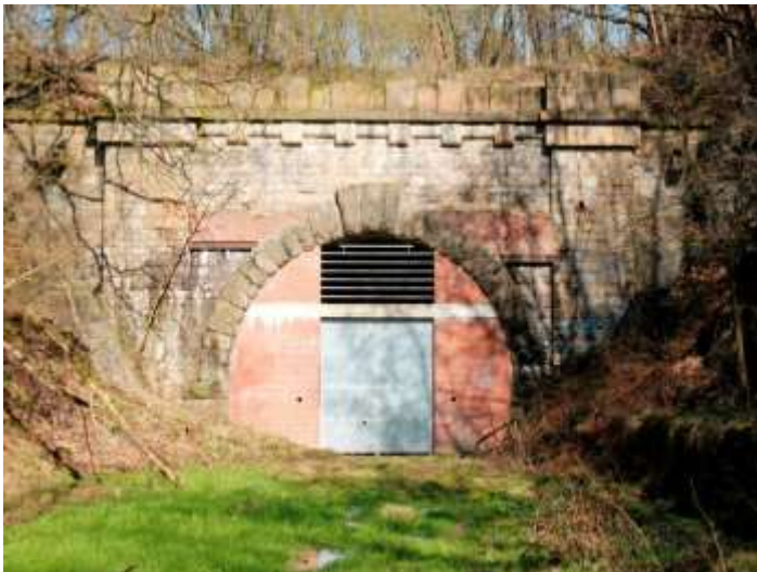
Abb. 13.: Silscheder Tunnel - Südende 2019
