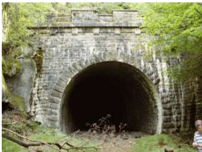
Abb. 12: Silscheder Tunnel - Nordportal 2007 (Foto: VSO)
